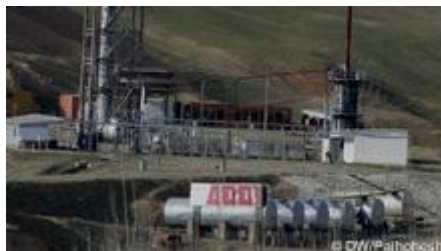
تاسیسات جدید چاه نفت انگوت
